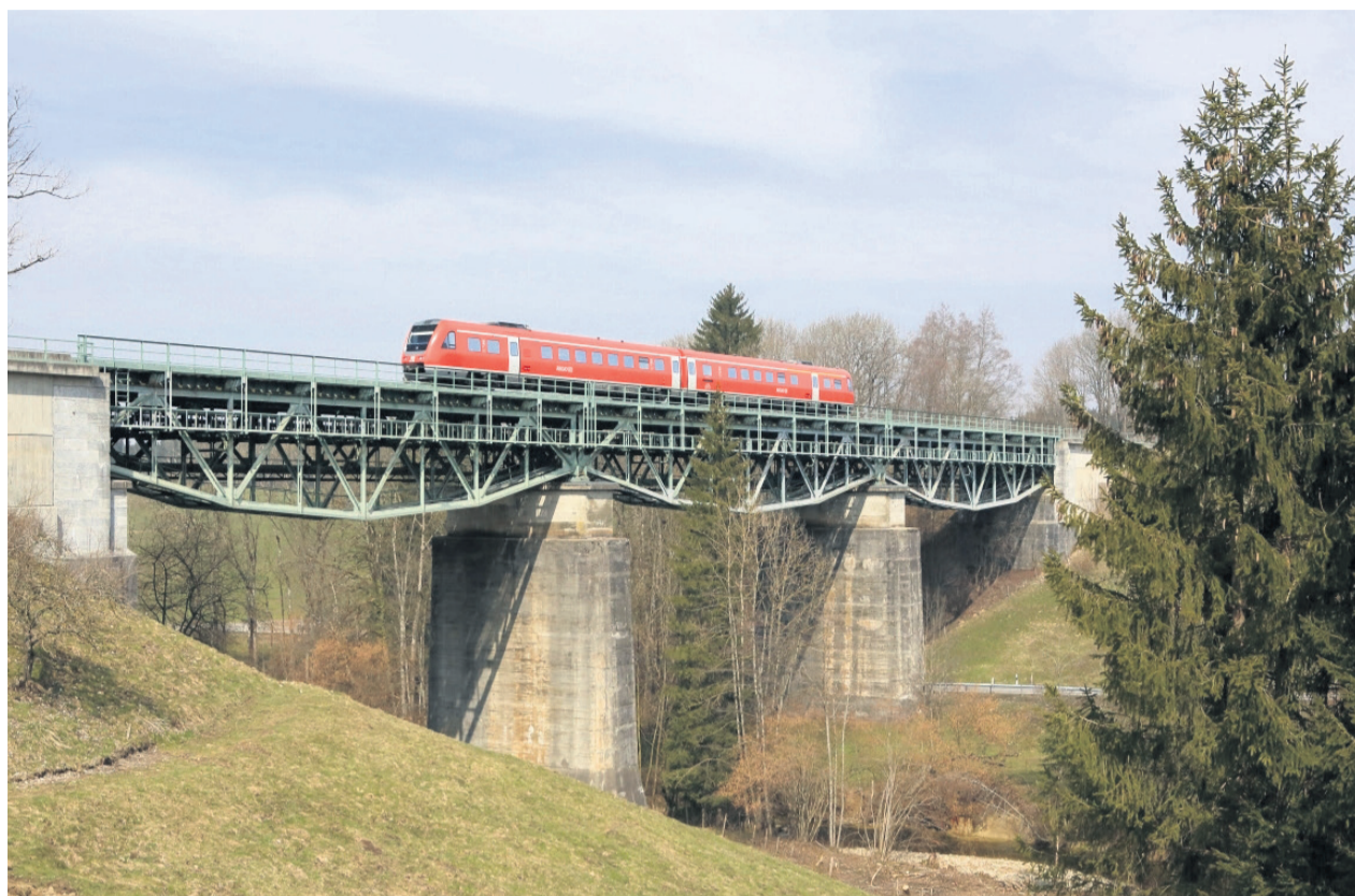
Eine von 25718 Eisenbahnbrücken in Deutschland: die Hämmerlebrücke in Maria-Thann in der Nähe von Lindau. Diese Brücke ist sanierungsbedürftig, aber wenigstens noch zu retten. Nicht so über 1000 andere Brücken. Bild zvg/DB
